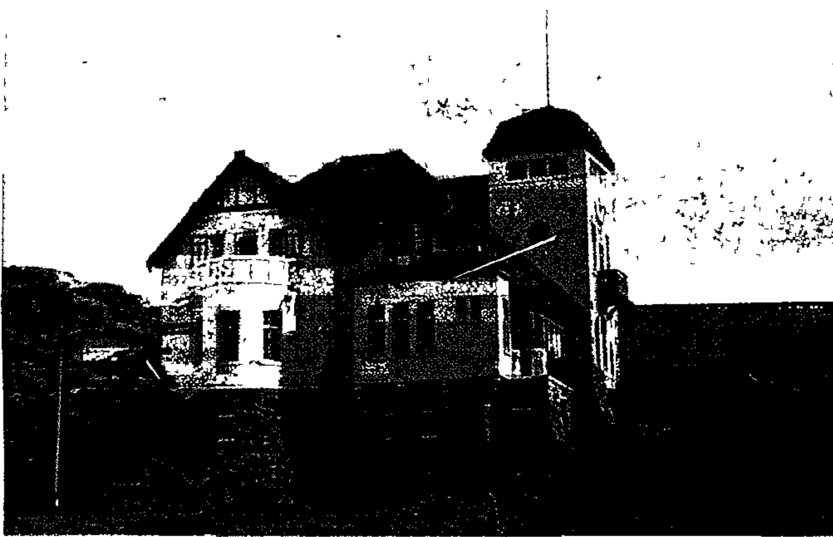
EEN van Lüderitz se spoghuse. Dit is spesiaal gebou vir die Duitse kroonprins om in te bly tydens staatsbesoeke, maar hy het Suidwes nooit besoek nie. Vandag bly Lüderitz se maaistraat hier.
